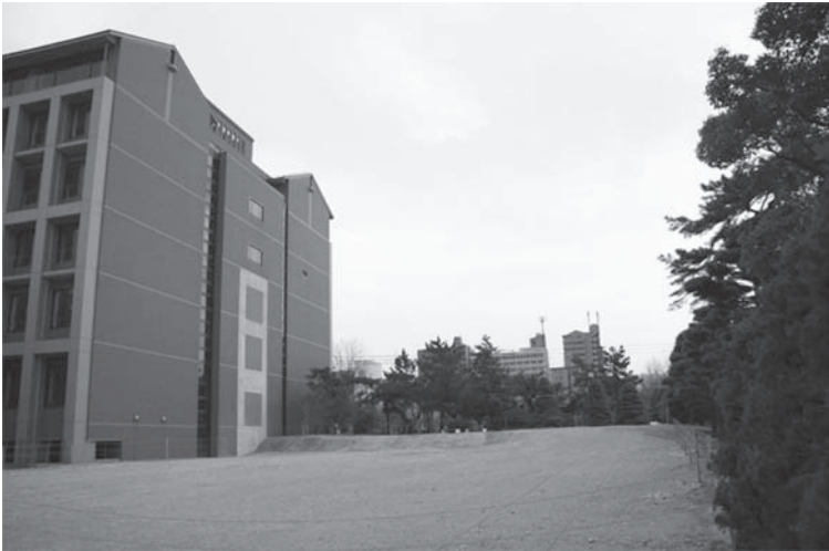
図版9 ランキン・チャペル解体後、いよいよ新チャペル起工のため更地に整備された1号館西側の敷地。2007年1月5日筆者撮影。
