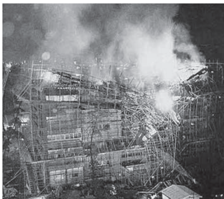
図版1 1968年6月2日夜、米空軍ジェット戦闘機ファントムの墜落によって炎上する建設中の九州大学工学部大型計算機センター。画像出典は http://www.eecs.kyushu-u.ac.jp/outline/enkaku/index.html 。
