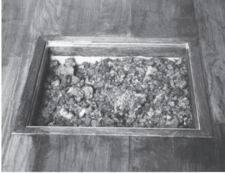
床下の防音のために使われたというコークス（石炭殻）
